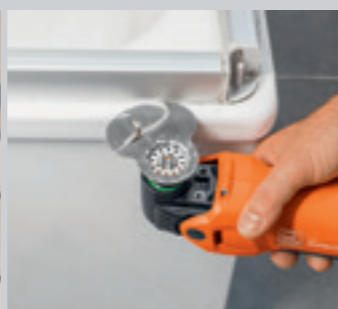
Elastisk tetningsmasse løses perfekt før ny fugging.
