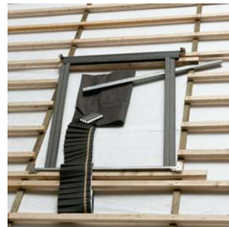
BDX 2000 karmisoleringsramme m/ undertakskrave og avvanningsrenne
